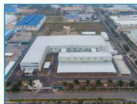
対松堂ベトナム 第2工場 (2020年12月竣工)
